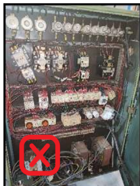
Ejemplos de armarios, botoneras y cableado en mal estado.
