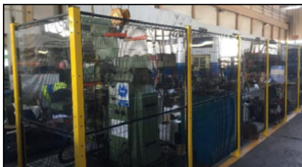
Ejemplo de protección con vallado perimetral. Enlace a la web de vallado.
