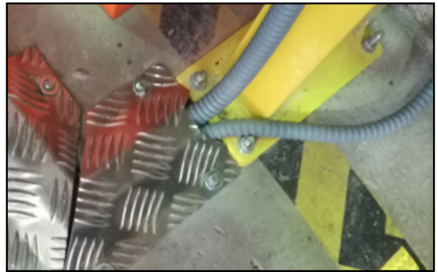
Ejemplos de acometidas en buenas condiciones.
