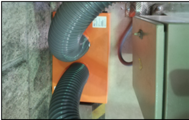
Ejemplos de acometidas en buenas condiciones.
