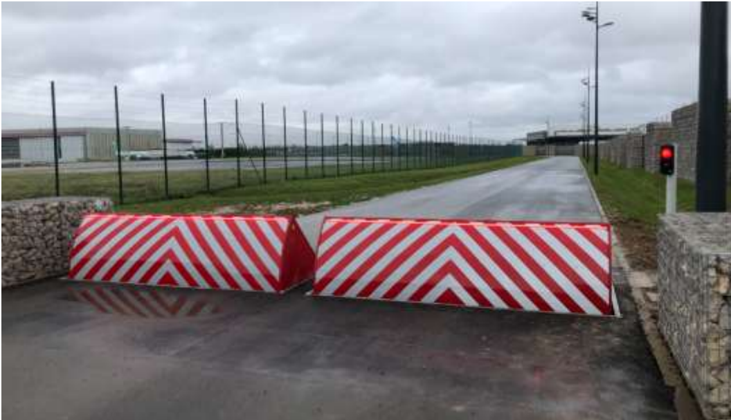
Barreras de cuña de profundidad
