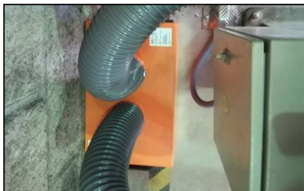
Ejemplos de acometidas en buenas condiciones.
