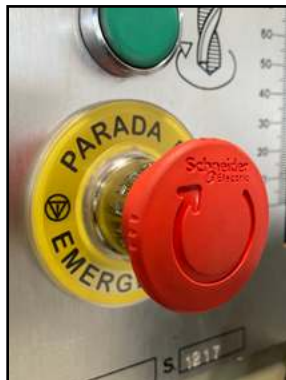
Parada de emergencia acorde a la normativa.
