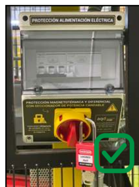
Ejemplos de armarios, caja marcha-paro ( enlace web ) y protección de alimentación eléctrica ( enlace a web ).
