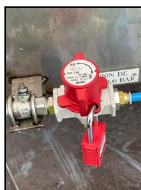
Ejemplos dispositivos de desconexión de energías con sistema de consignación. Enlace web a protección de alimentación eléctrica
