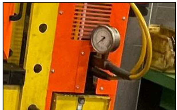
Ejemplo de acometidas en buen estado.
