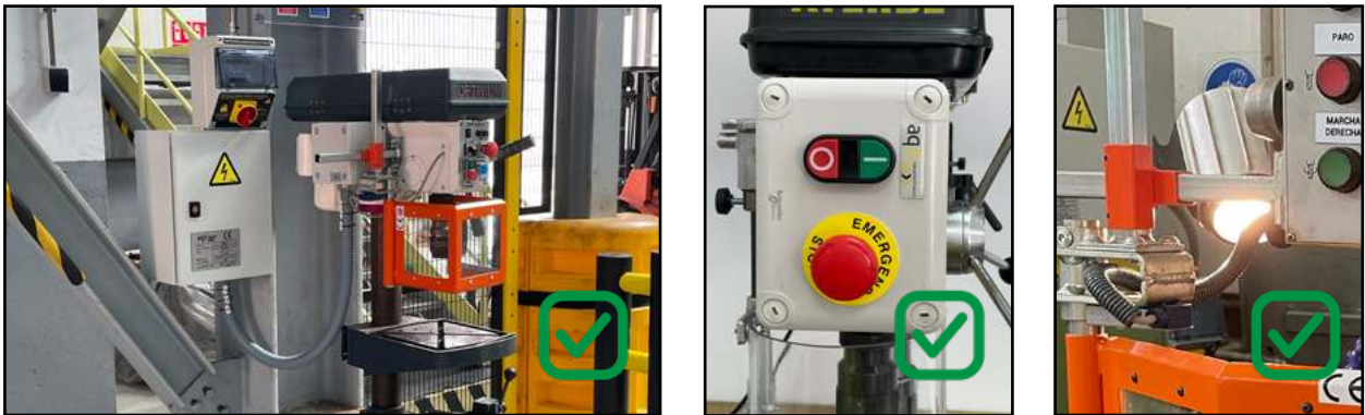
Ejemplos de armario, acometida, botoneras, parada de emergencia e iluminación adecuados.
