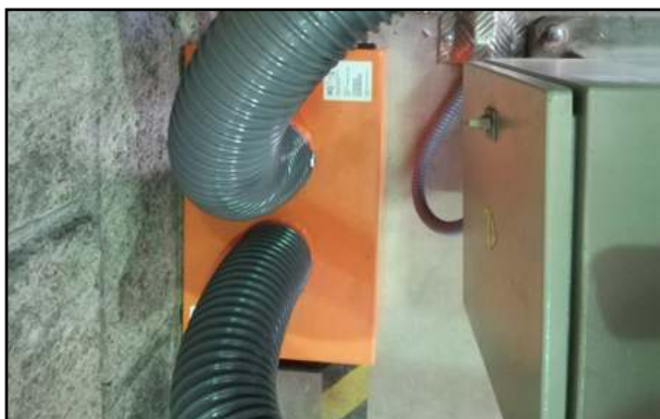
Ejemplos de acometidas en buenas condiciones.
