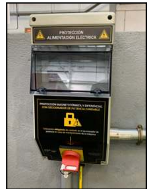
Ejemplos de dispositivos de desconexión de potencia con protección magnetotérmica y diferencial, y neumática (cuando proceda). Enlace web a la protección de alimentación eléctrica
