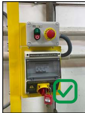
Ejemplos de acometidas, botoneras y cajas de protección adecuados.
