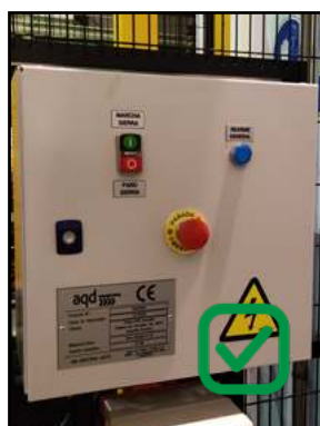
Ejemplos de armarios, caja marcha-paro ( enlace web ) y protección de alimentación eléctrica ( enlace a web ).
