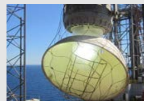
Pantalla de luz y protección contra impactos desprendidas debido a la corrosión.
